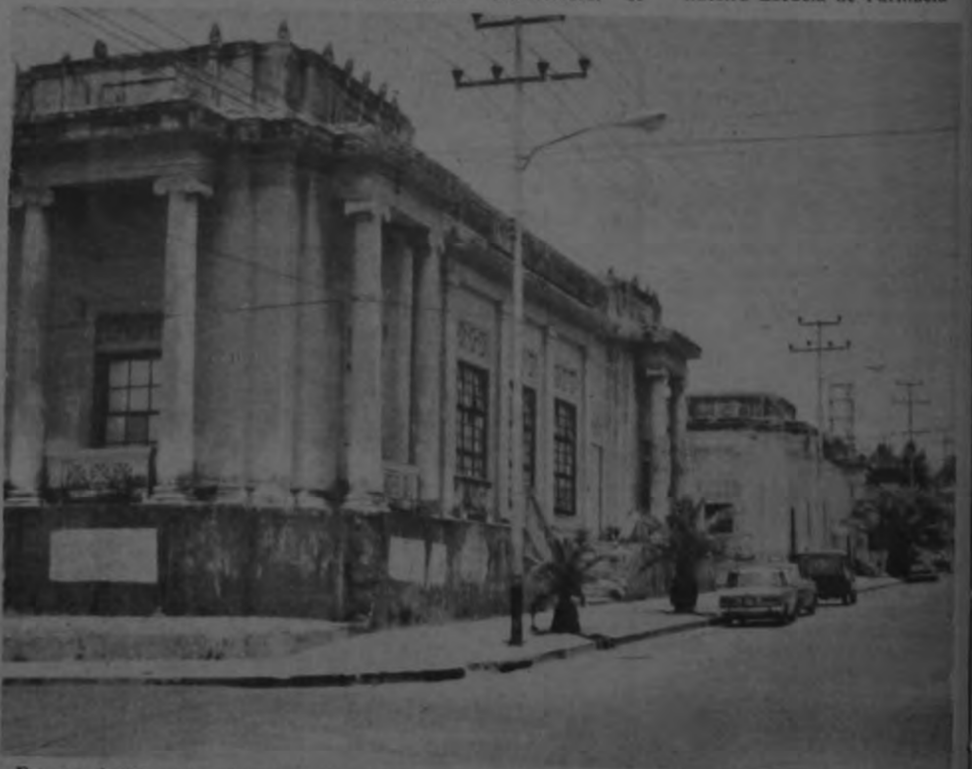
Este era el edificio de la Escuela de Farmacia, inaugurado en 1928 y demolido en 1974. Estaba ubicado entre la calle 19 y avenida 8ª.
